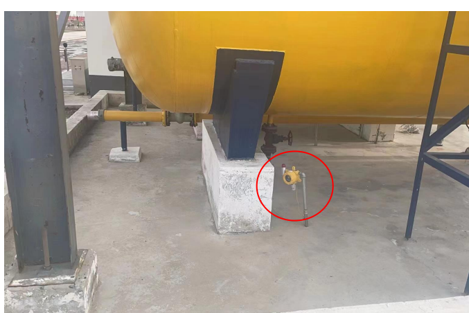
甲醇储罐下可燃气体报警仪
