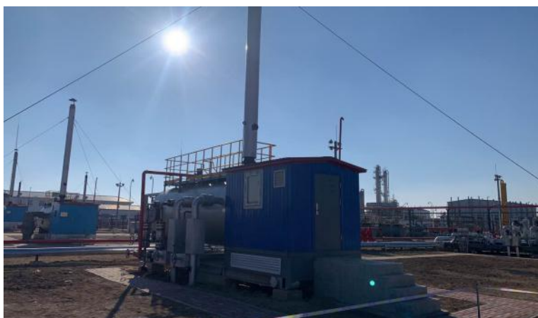
图 2.5-3 集气站加热炉
