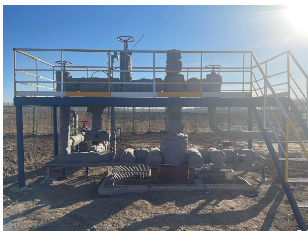
气井井口全部密闭，设备阀门进行密封、防腐处理
